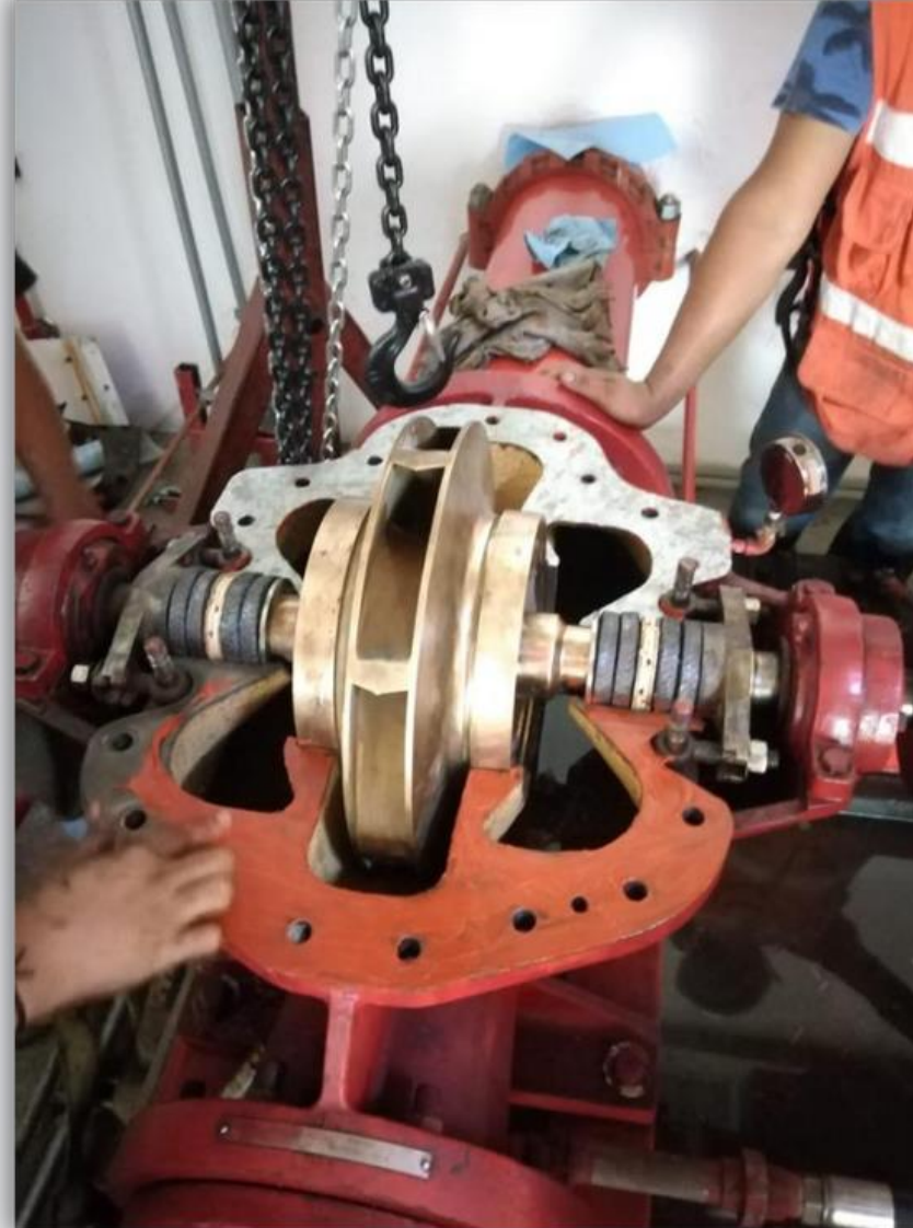
Mantenimiento mayor a bomba contra incendio
