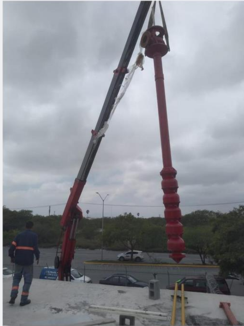
Reparación de bomba de turbina vertical
