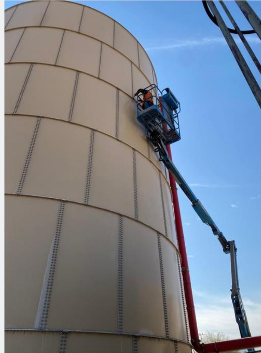
Reparación de fuga exterior en tanque de almacenamiento
