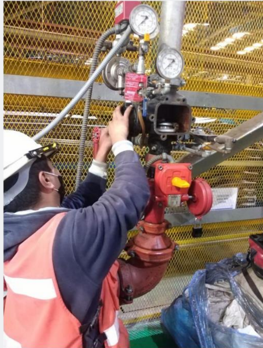
Mantenimiento anual a sistema de preacción
