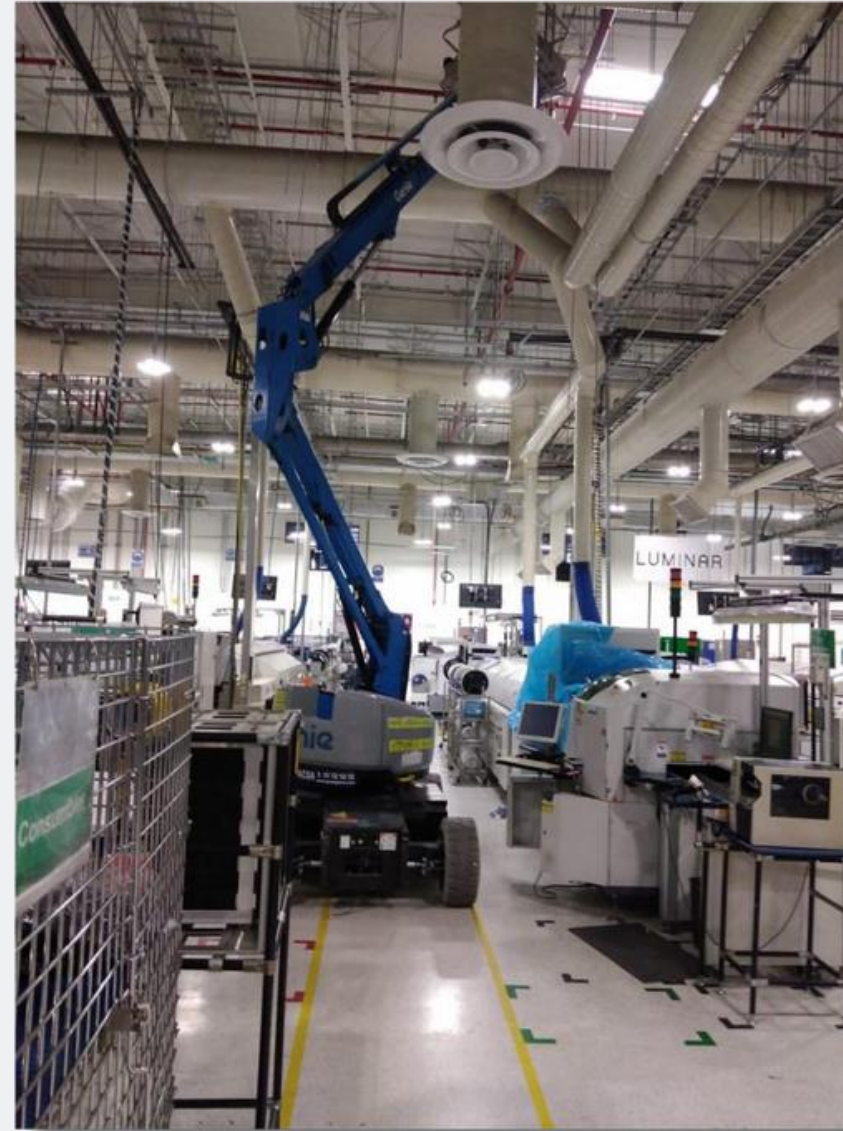
Reparación de fuga en tubería SCI
