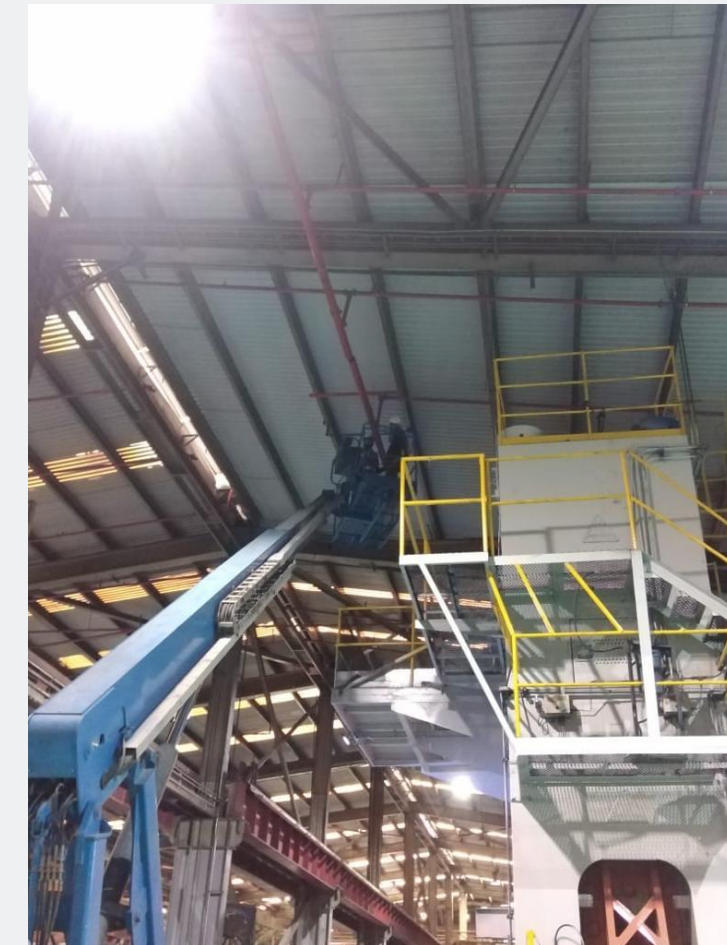
Instalacion de sistemas de rociadores en prensa.
