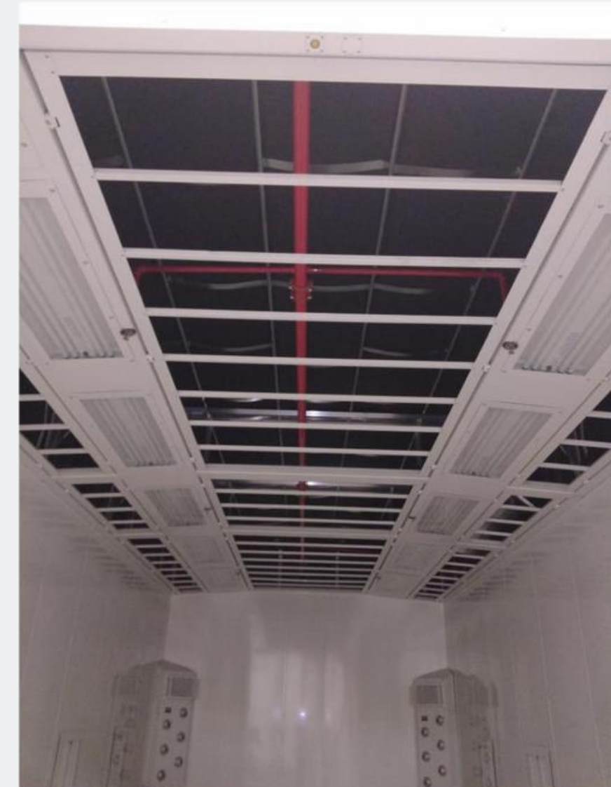
Instalación de sistema de rociadores en cabina de pintura
